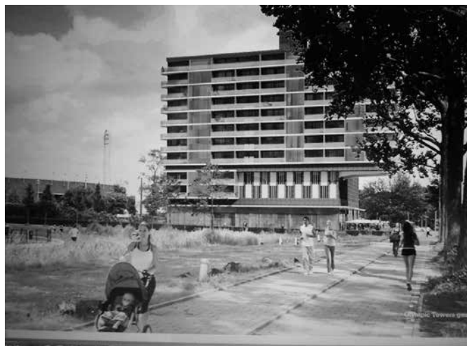
Weet u het nog? De hoofdmoot wordt 10 verdiepingen maar de 55 meter hoge toren kon toen nog achter het loof van de bomen schuilen!
