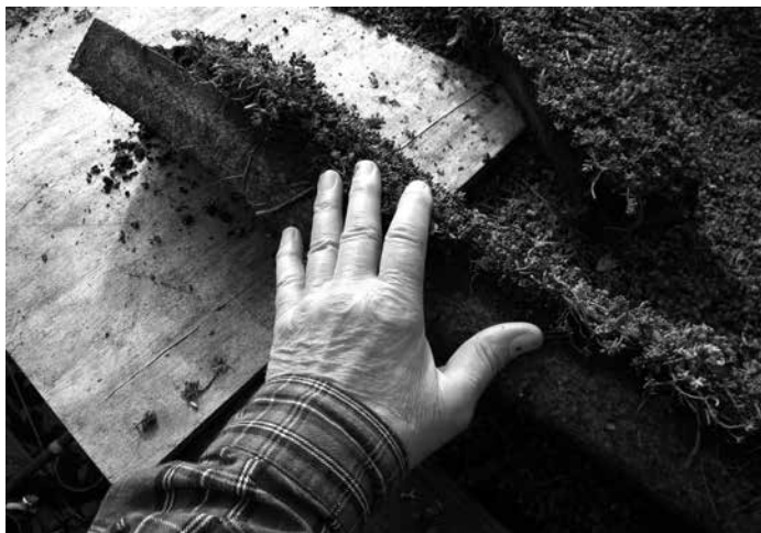
Doorsnee van een cassette van dichtbij met intieme kijk op de sedumplantjes.
