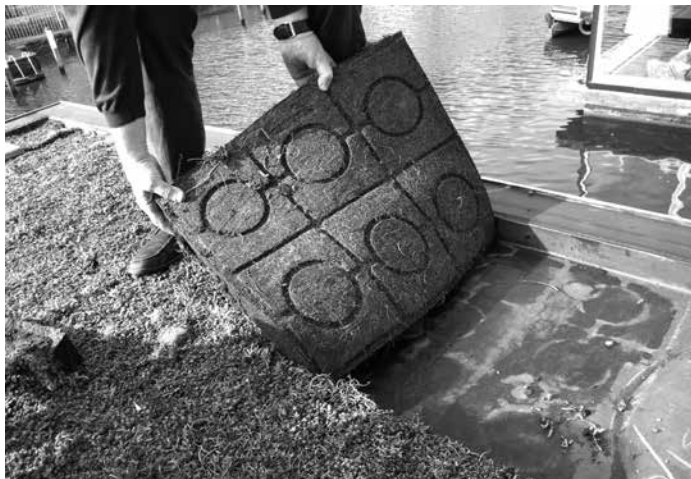
De onderzijde van een cassette, zojuist uit z'n vak getild om deze foto te kunnen maken. De uitsneden zijn er om bij overmatige regenval de afwatering te bevorderen. Zie hoe het dak onder die kanalen droog is gebleven.
