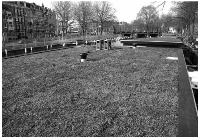
Aan de Marnixkade: 100 vierkante meters in een korte middag kant en klaar! Merk op dat de naden tussen de cassettes nu al bijna onzichtbaar zijn.
