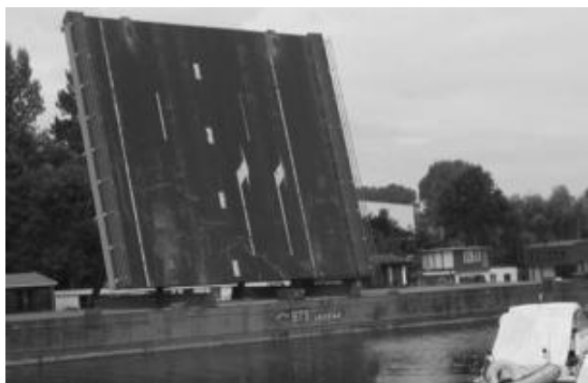
De oude brug wordt afgevoerd (foto IE)
