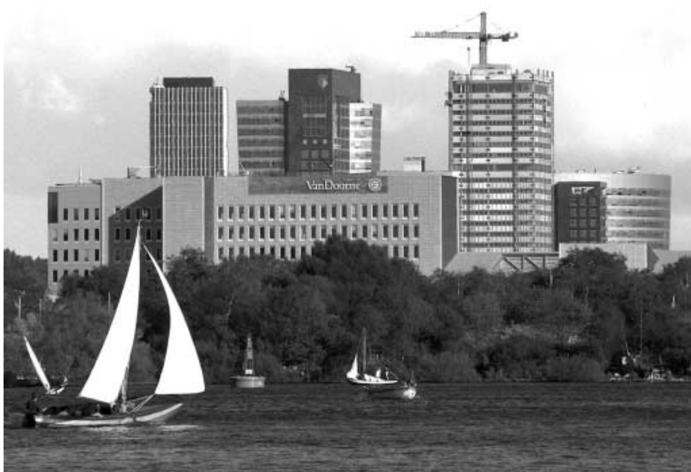
Koelinstallatie voor 'Manhattan aan De Nieuwe Meer'
