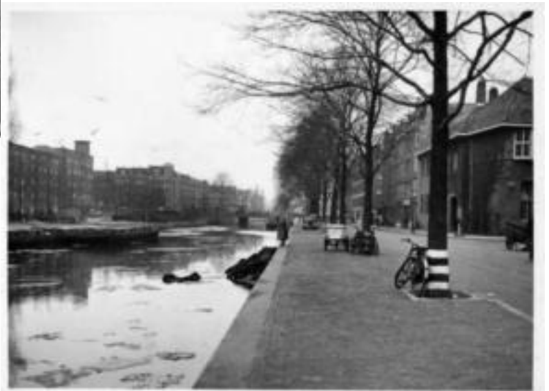
Maart 1940: Gezien in de richting van de Stadhouderskade. Links de Hobbemakade en rechts de Ruijsdaelkade. Op de achtergrond de brug voor de Ceintuurbaan. In het verschieft het baan. In het verschieft het Rijksmuseum. (Gemeentearchief: 010003017765)
