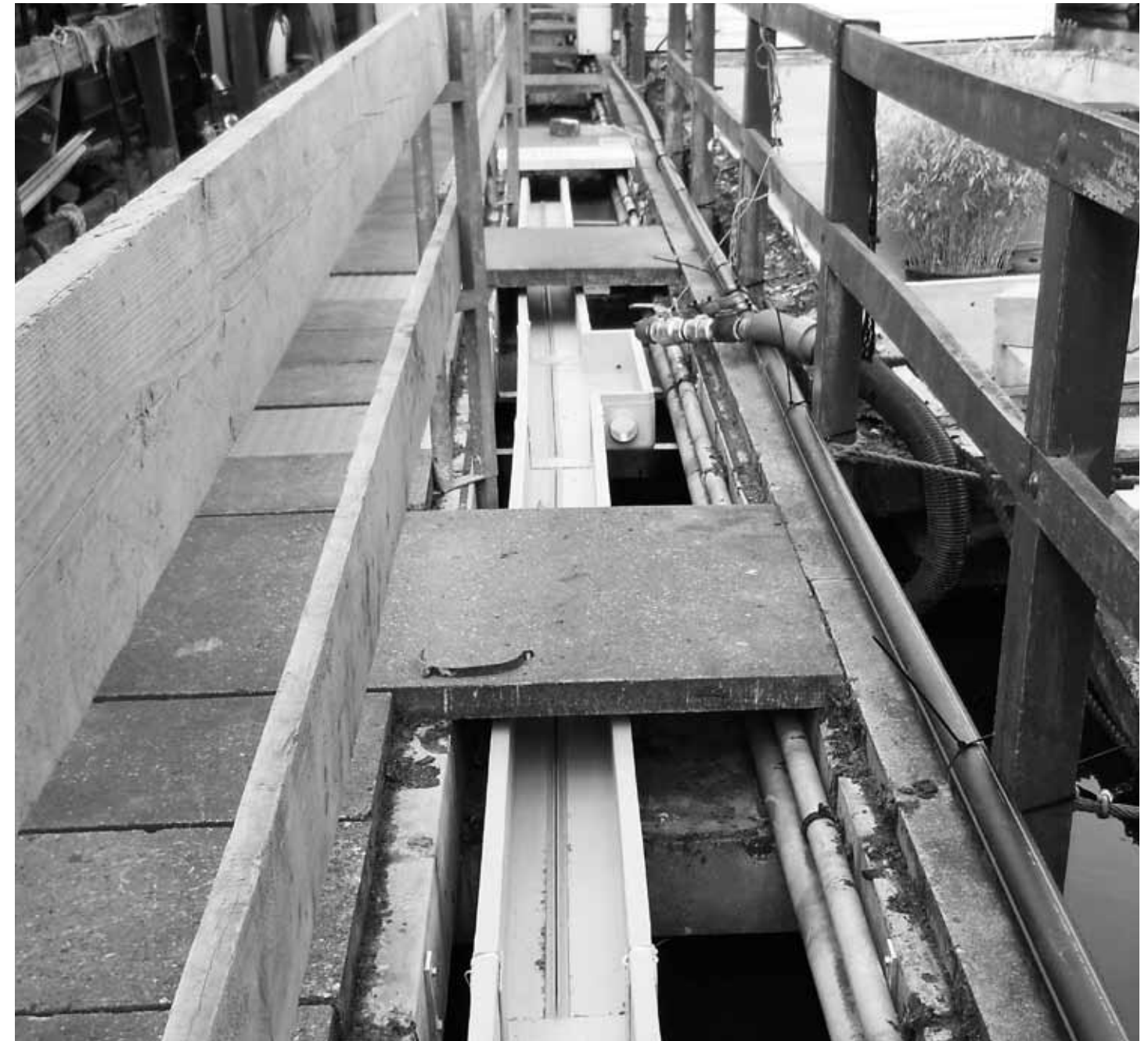
De nieuwe behuizing van de water- en rioolleidingen.
