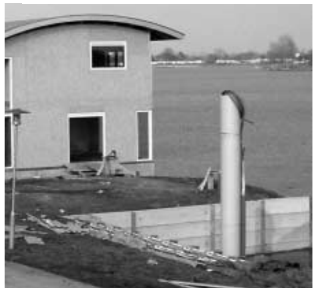
Vakantiewoningen in aanbouw op De Gouden Ham, Maasbommel (DS)
