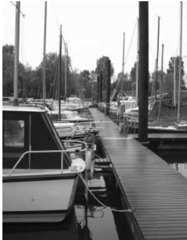
Steigers aan hoge palen in een haven aan de Nederrijn in Wageningen (DS)
