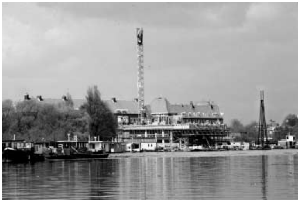
De Schinkel in aanbouw met links de woonboten van het Jaagpad (ca. 1964)
