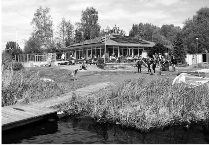
Overzicht van het clubhuis vanaf het water, met de zonnepanelen aan het zuidwesten van het dak en de zonneboilers aan het zuidoosten
