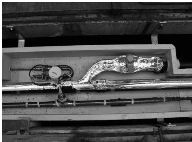
Het werk onder het loopvlak werd keurig uitgevoerd!
