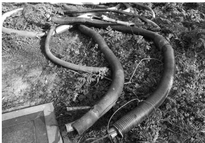
De oude verbindingen tussen de woonboten en de steigers waren integraal aan vervanging toe.
