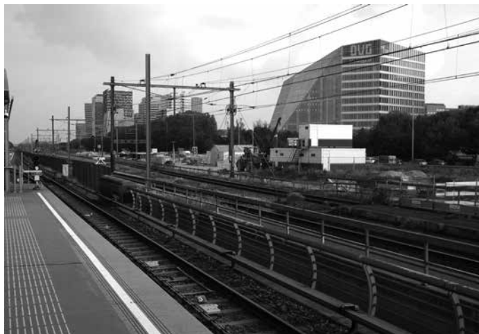
Daar op het talud is er inmiddels bijna sprake van een heel eigen bouwvakkers dorp!
