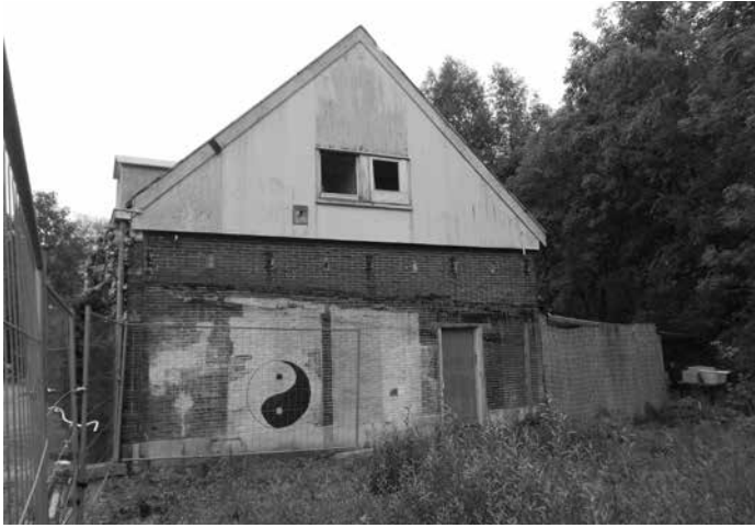
Hard bewijs van bewoning is anders, maar dat wasgerei zal geen jarenlang in weer en wind zijn blijven staan.
