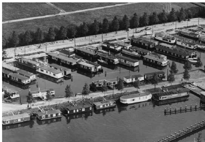
Jachthavenweg met sluis, september 1961
