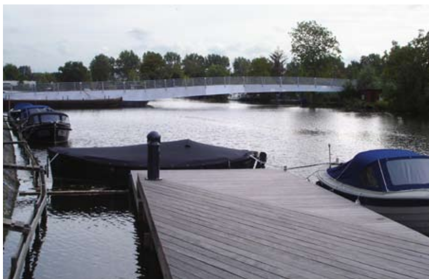
De Jan Wilsbrug: elders gebouwd, hier naartoe gevaren en in de eerste week van september op z'n plaats gezet.
