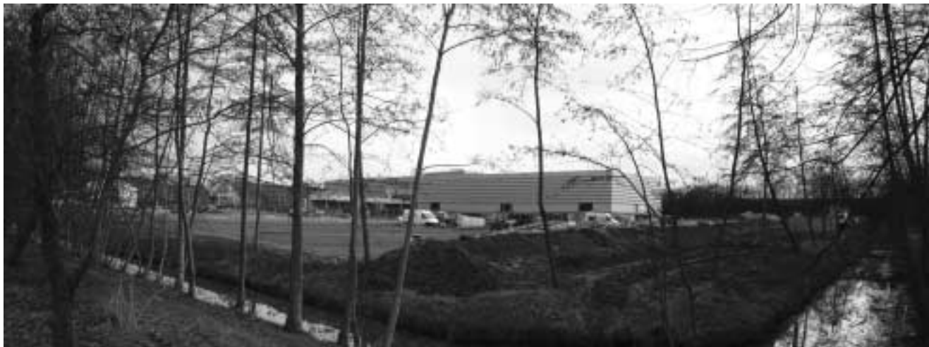
Werkzaamheden op het terrein van het Frans Otten Stadion (IE)
