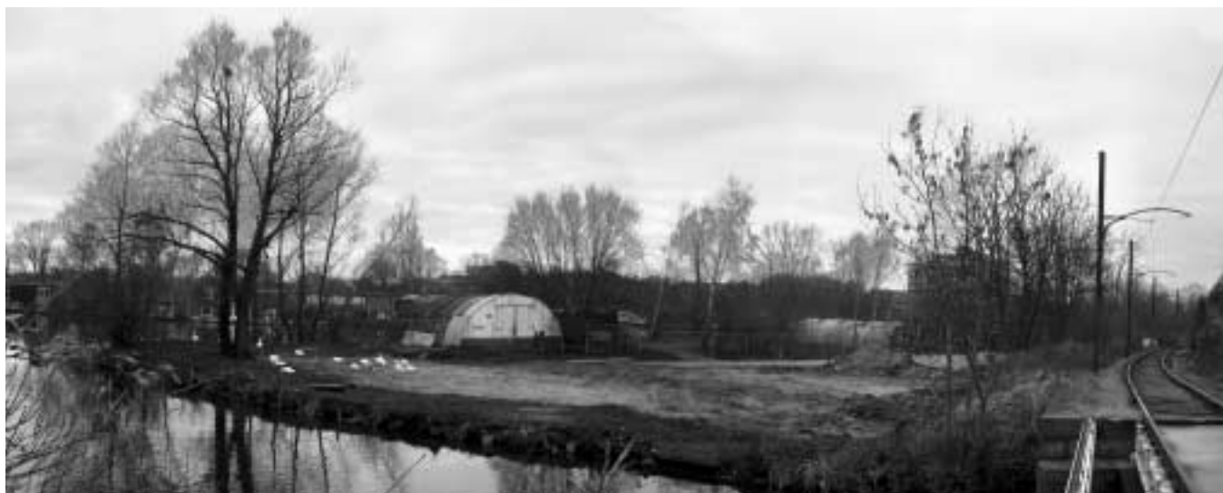
Voorbereidend werk aan het Parkeiland (IE)
