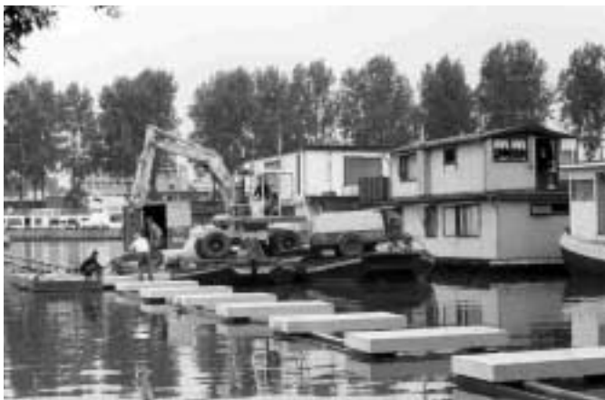
Betonplaten voor de nieuwe steiger worden aangevoerd (EvdV)
