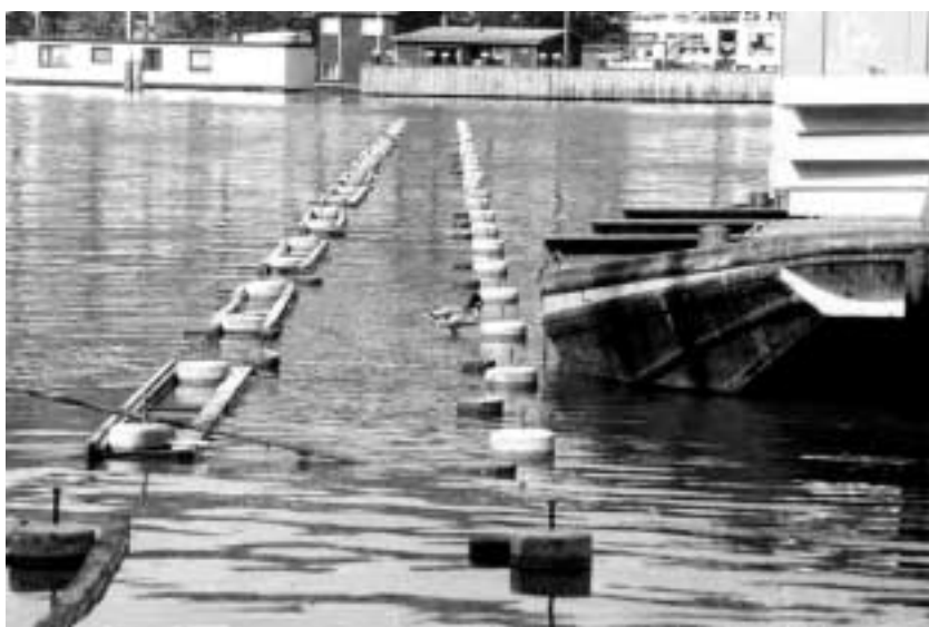
Palen van de nieuwe steigers worden geplaatst (EvdV)
