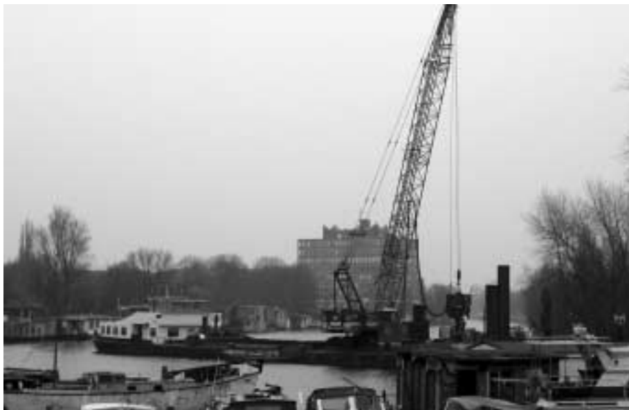
Intillen van de damwanden voor riolering onder de Schinkel (IE)
