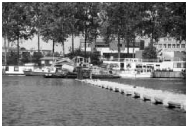
Vervanging steiger nadert voltooiing (DS)
