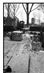
De leidingen aan het IJsbanaanpad
