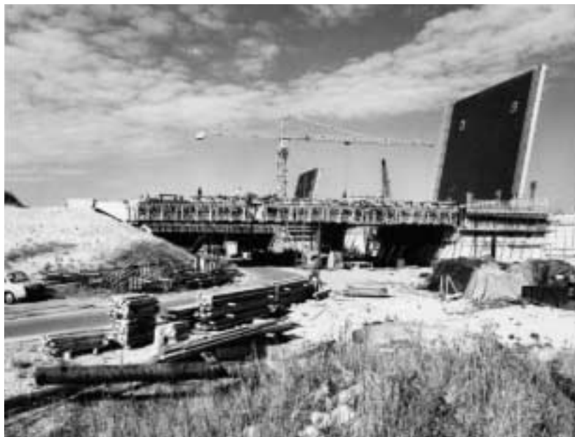
Foto 3: J.M. Arsath Ro'is: Jaagpad, bouw van de brug als onderdeel van de ringweg (Gemeentearchief 010122003829)
